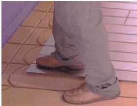
Votre plancher chauffant est prêt à recevoir un plancher bois ou du fermacell pour coller du carrelage. Des lambourdes, en option, permettent la pose vissée ou collé / cloué de parquet
