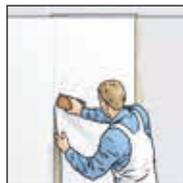
**5.** Coller les lés d'aplomb, bord à bord à joints vifs. Maroufler à l'aide d'une brosse de tapisserie ou d'un rouleau en caoutchouc.
